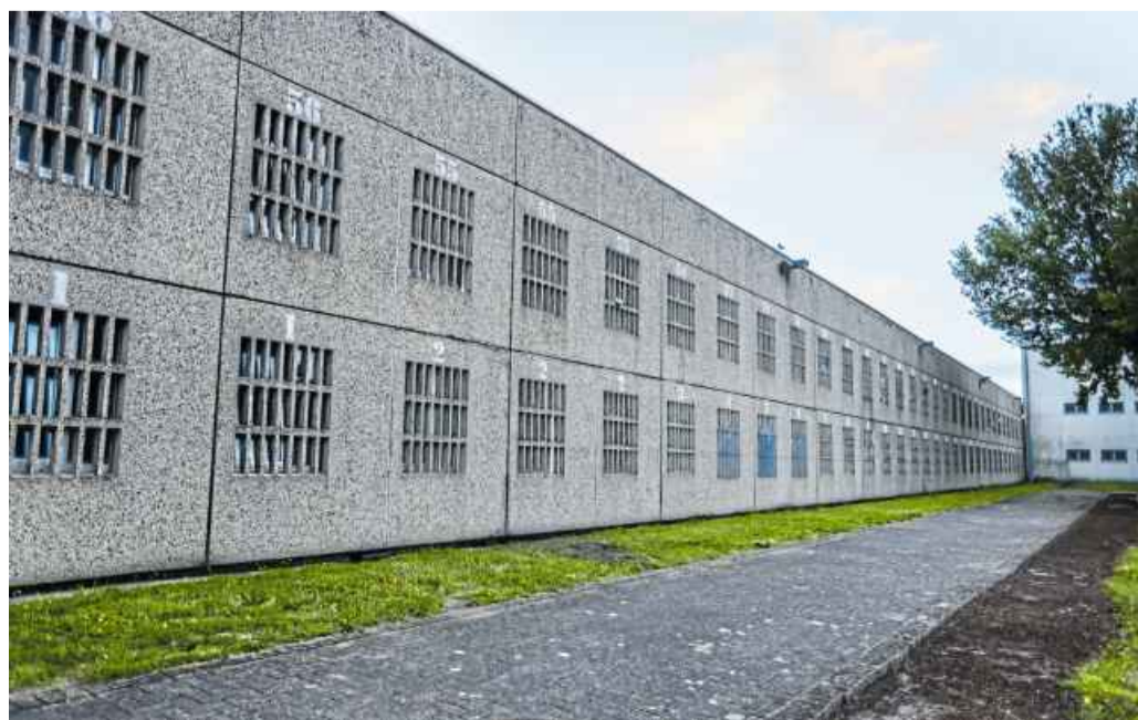
Die Gefängnisarchitektur der Zellenblöcke stammt noch aus den 70er Jahren des vergangenen Jahrhun- derts. Die gleichen Zahlen an der Mauer weisen auf eine Gemeinschaftszelle hin.
